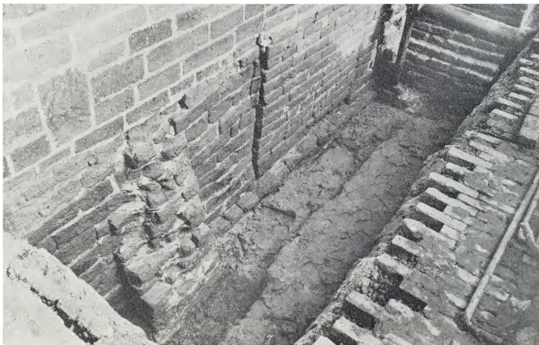
Afbeelding 3. Verbindingen van de dwarsmuren van de opgegraven zuidelijke annex.
