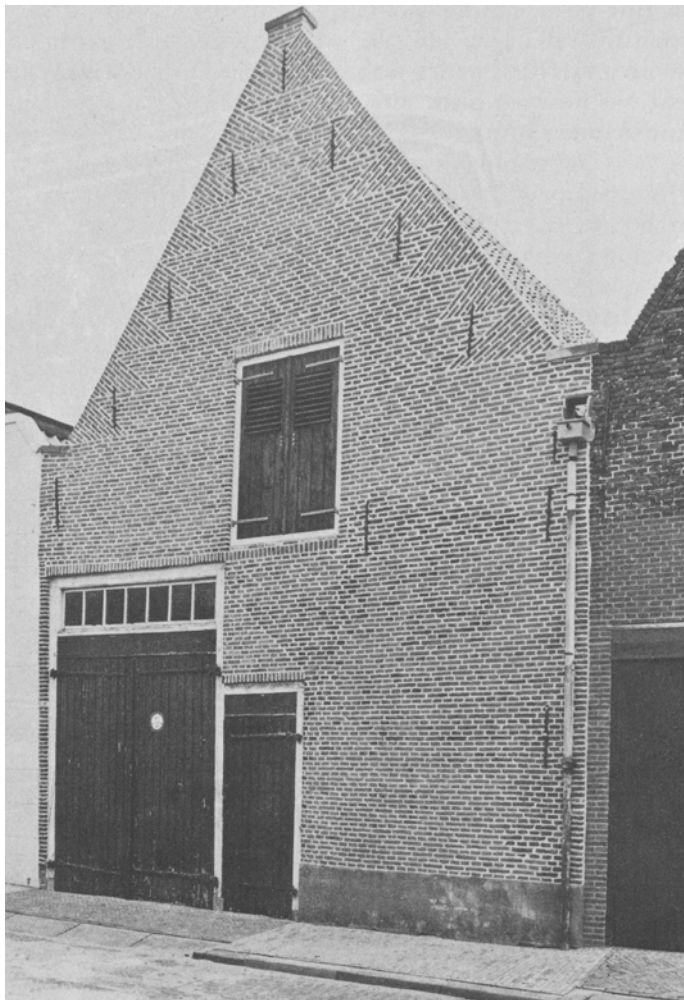
De achtergevel van de stal die voor 1983 is gerestaureerd.
