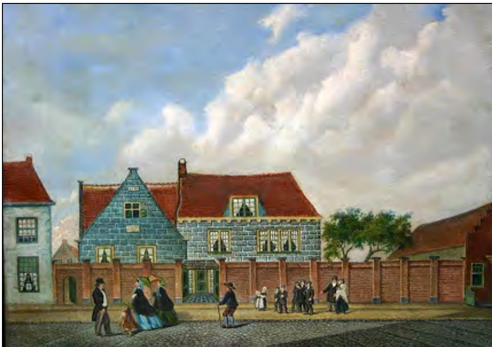
Afbeelding 1. J.H. Rotscheid, Delfshaven, Weeshuis van Schoonhoven, zonder jaartal, omstreeks september 1855. De Gildekeurkamer van de goud- en zilversmeden te Schoonhoven was van 1705 tot 1809 gevestigd op de 1 e verdieping van het Weeshuis, naar we aannemen, achter het grote raam. 7
