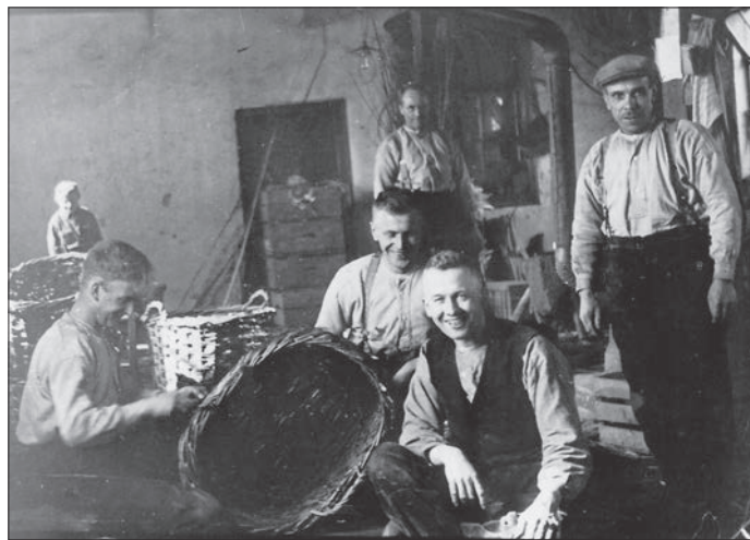
1935: Mandenmakers in de breiersschuur van Nicolaas (Klaas) de Lange aan de Prinsengracht: v.l.n.r. Floor de Lange (kind), Kees de Lange, Koos de Lange, Freek vd Heuvel, Gerrit de Lange en Jan de Lange (achteraan).
