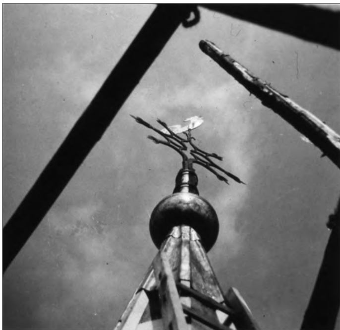
De bol is gemaakt uit twee delen, gedreven (geklopt met een bolhamer) uit een koperen plaat.
