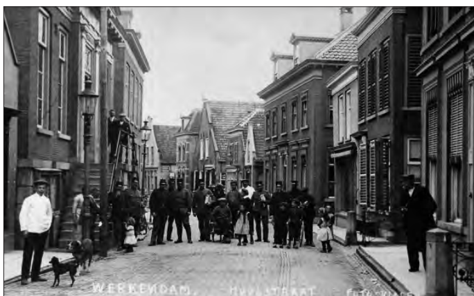
Het pand Hoogstraat 37 in Werkendam in zijn huidige vorm dateert van 1810, maar bestaat uit twee verschillende panden met aanbouwen die met een corridor aan elkaar zijn verbonden. Het hoofdgebouw staat aan de Hoogstraat, het tweede deel, het koetshuis ligt achter Hoogstraat 35. Rond 1810 wordt het bewoond door de latere burgemeester Bastiaan Verheij van den Bogaard en zijn vrouw Agatha Henrika van Houweninge. Het echtpaar sterft kinderloos en schenkt het pand aan een nicht die gehuwd is met Gijsbert van Tienhoven, later woont zijn zoon Johannes Jacobus (burgemeester van Werkendam) in het pand.
