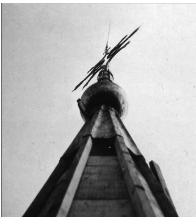
De bol onder het kruis op de toren is gemaakt door loodgietersbedrijf Teun Bouter uit de Fransestraat.
