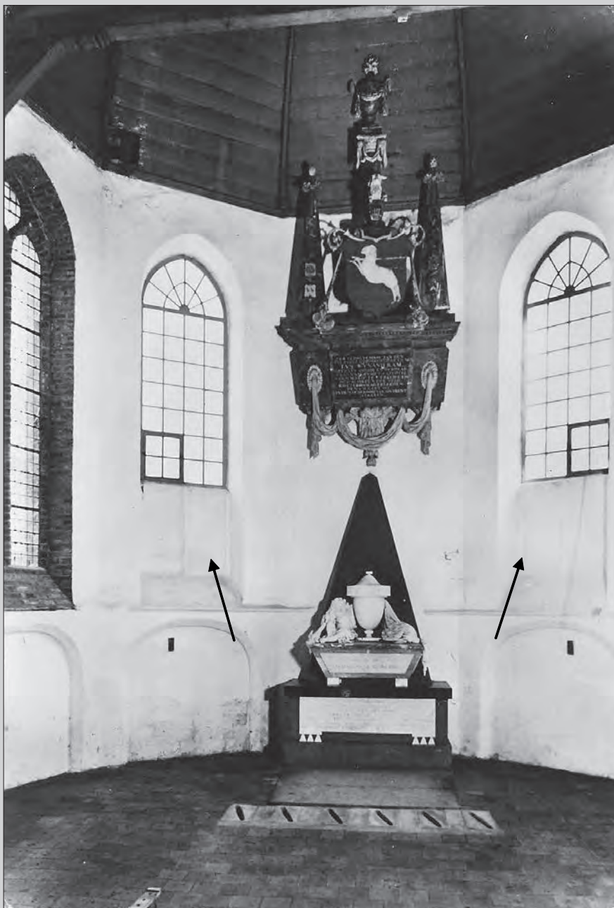
Twee gedeeltelijk dichtgemetselde ramen in het koor.
