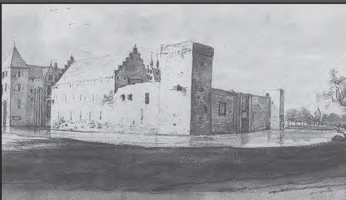
9. Het slot te Langerak in 1646/47 gezien vanuit het zuidwesten. R. Roghman. Rijksprentenkabinet inv. 1888 A 1772. Amsterdam.
