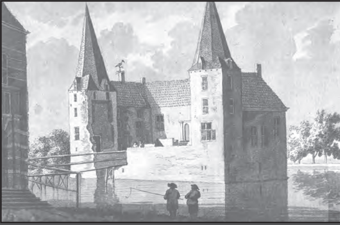
14. De hoofdburcht van het slot te Langerak gezien vanuit het zuidwesten (na 1733) H. Tavenier. Koninklijk Huisarchief, Atlas Munnicks van Cleef nr. 721.
