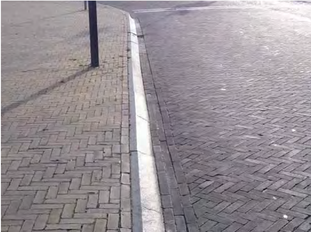
Referentie van twee tonen gebakken klinkers en een schuine band ter afscheiding en overbrugging van het hoogteverschil
