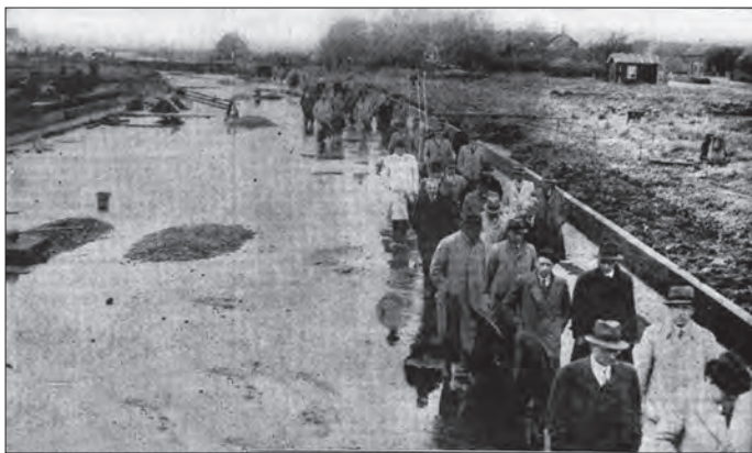
▲ Inspectie bij Goudriaan (brug over de Dwarsgang) van de nieuwe provinciale weg van Nieuwpoort naar Schelluinen. (De 5 Rivieren, 14 oktober 1938).
