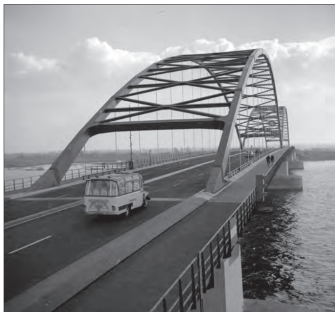
▲ De nieuwe Merwedebrug bij Gorinchem in 1961.
