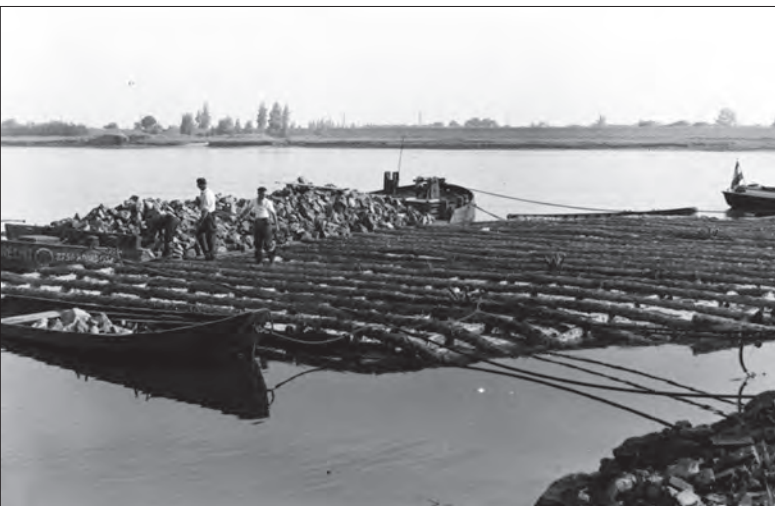
▲ Zinkstuk nieuwe samenstelling bij Ameide. Het deel tegen de kop van de krib is aan de grond, het overige deel wordt gelijkmatig belast. (Historisch archief van periode 1900-1960. (Beeldbank Rijkswaterstaat).
